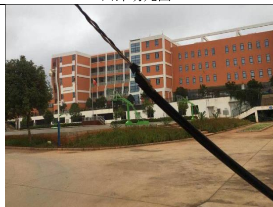
昆明空港第一小学（已安装隔声措施）
