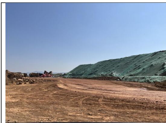
建设施工现场
