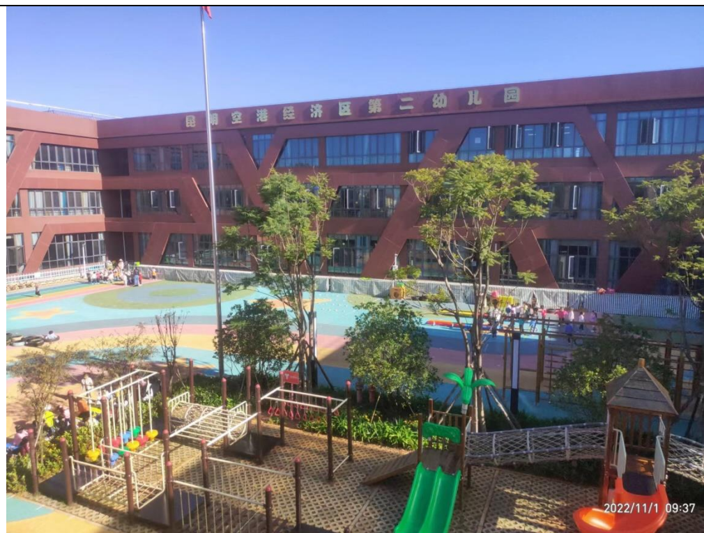
昆明空港经济区第二幼儿园（已安装隔声窗）
