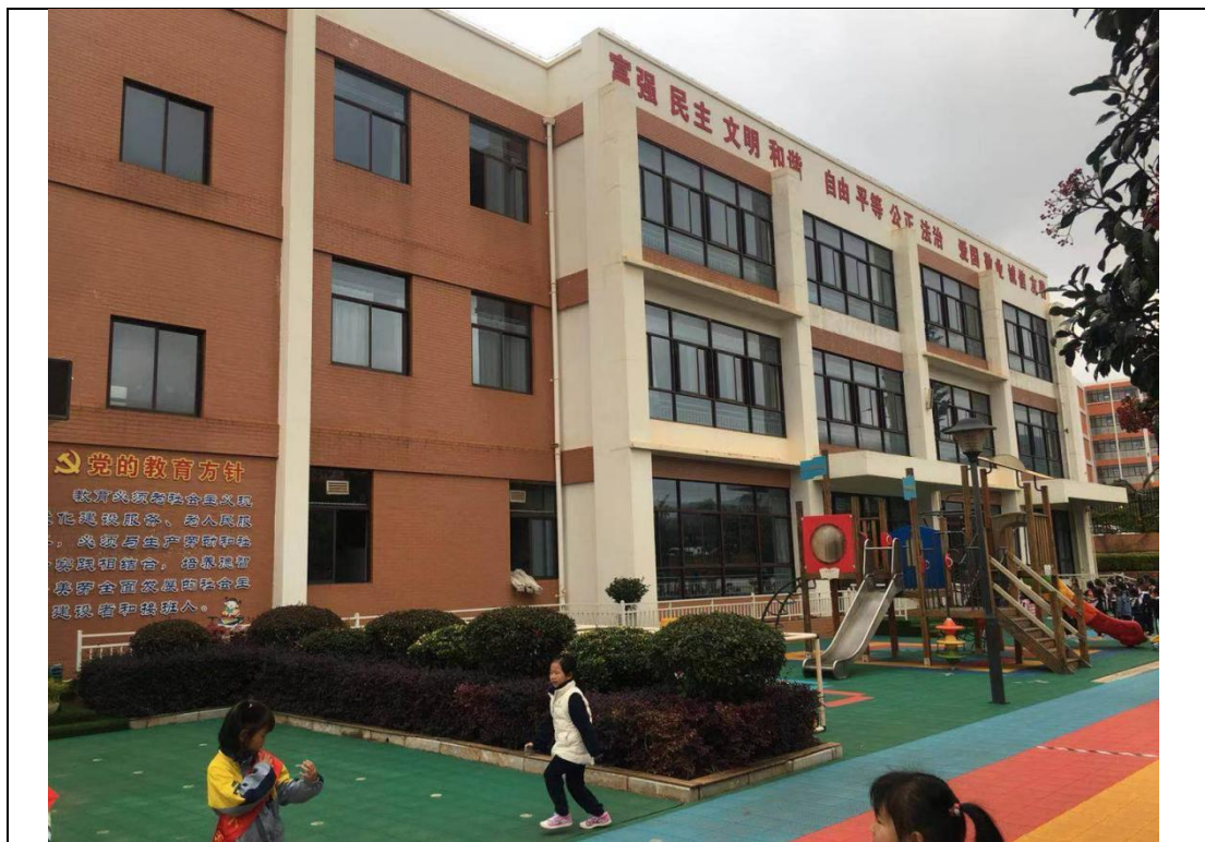
昆明空港经济区第一幼儿园（已安装隔声窗）
