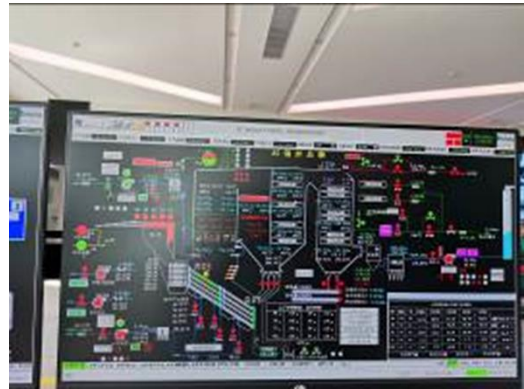
垃圾焚烧炉温自动控制系统
