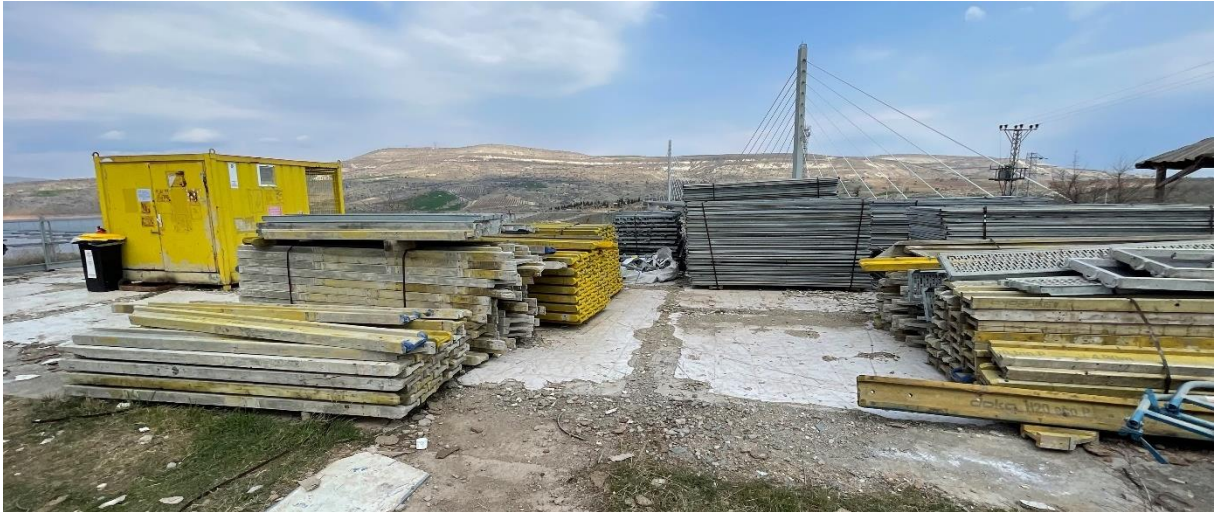
Şekil 48. Ağın Kamp Alanı- Malzeme Deposu
