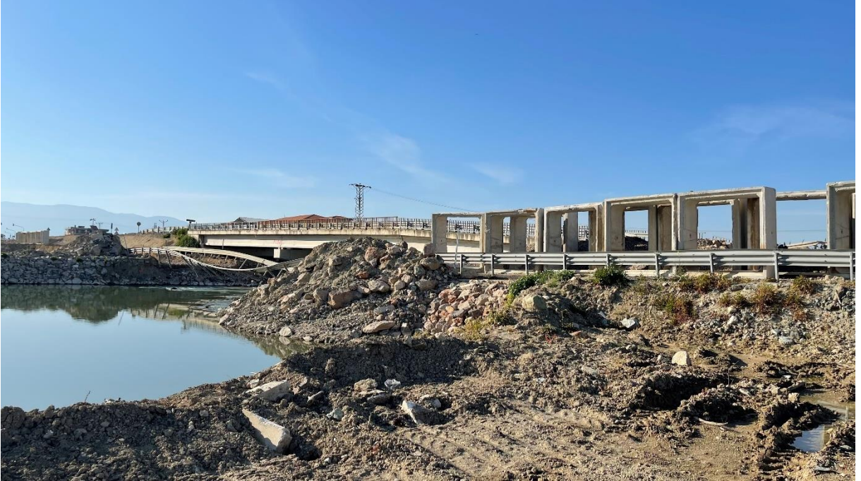
Şekil 15. Demirköprü İnşaat Alanı
