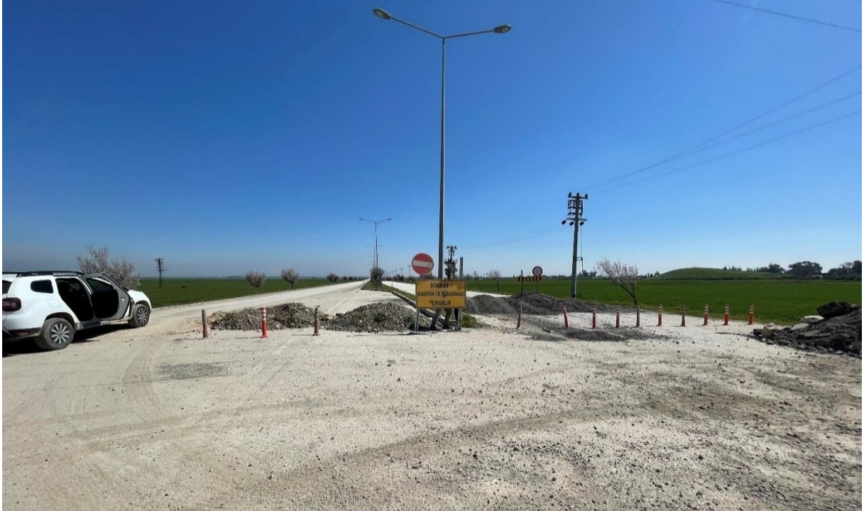
Şekil 20. Alt Proje İnşaat Girişi
