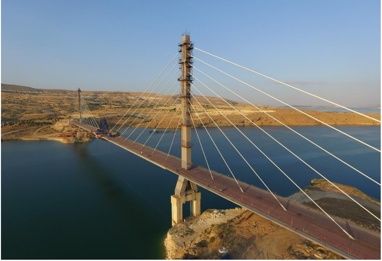
Şekil 45. Ağın Köprüsü Genel Görünüm
